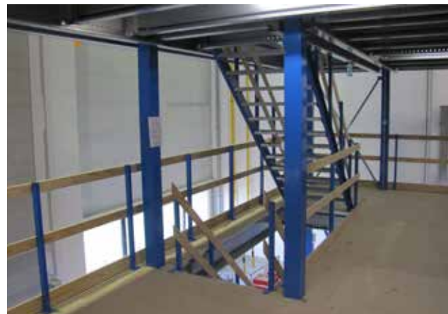
Különbféle magasságokhoz könnyen adaptálható, egyszerűen összeszerelhető lépcsők és korlátok.
